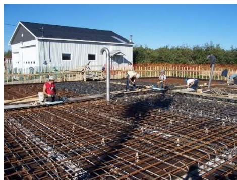
Construction d'un nouveau réservoir d'eau potable
