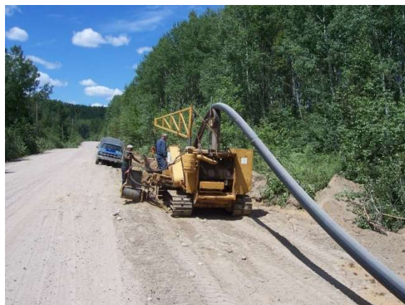
Pose d'une nouvelle conduite d'amenée d'eau potable vers le village
