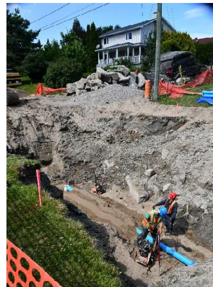
Travaux rue Jean-Paul-Darveau
